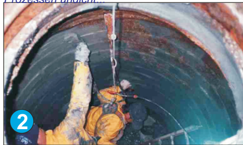
2. Nach der Abdichtung der Durchtrittsstellen mittels ENECRETE® WP , wird die Wandfläche mit zwei Lagen WS- der Dichtbeschichtung- überstrichen.
