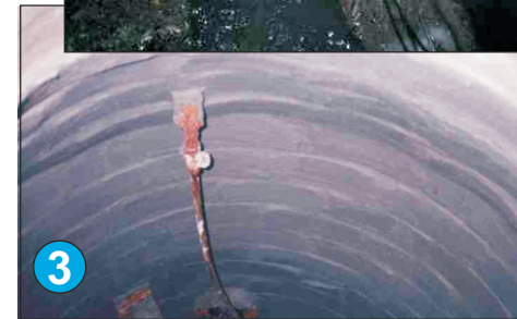
3. Das Ergebnis: Geschützt, abgedichtet und imprägniert- mit ENECRETE® WS in wenigen Schritten zum gewünschten Erfolg!
